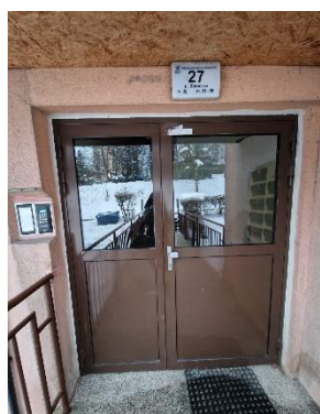
Wejście do budynku
