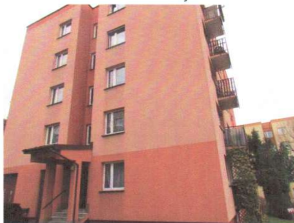
Blok przy ul Osadniczej 8 – wejście do budynku
