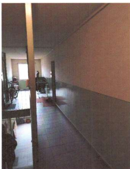
Widok klatki schodowej – 4 piętro
